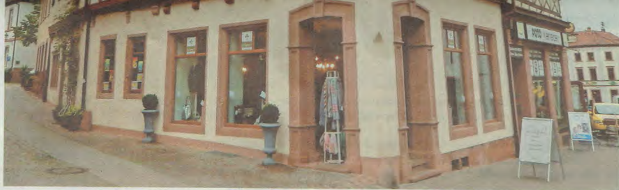
Das Eckhaus Turmstraße 1 hat ein in Lohr seltenes Schmuckfachwerk und einen Brunnen im Keller.
